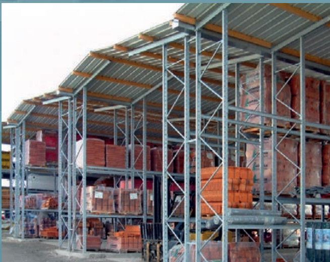
Otevřená hala s paletovými regály ke skladování stavebnin. Dvouřadý regál, kompletně pozinkovaný, namontovaný na základových patkách.
