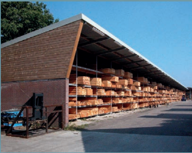
Ze tří stran uzavřená hala s paletovými regály ke skladování dřeva různého sortimentu a o různých rozměrech směrem do hloubky. Velký přesah střechy.
