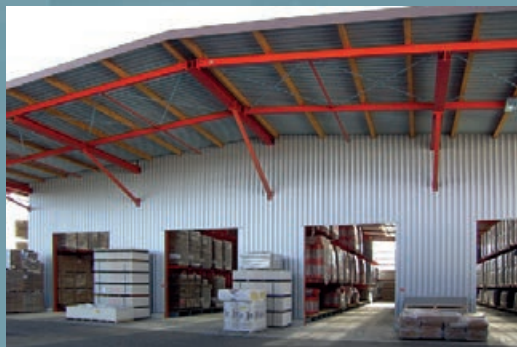
Výstavba regálových hal – uzavřené provedení: Včetně střešní krytiny a obložení stěn. Díky vestavbě vrat, únikových dveří a odvodnění se výstavba regálové haly stává kompletní.
