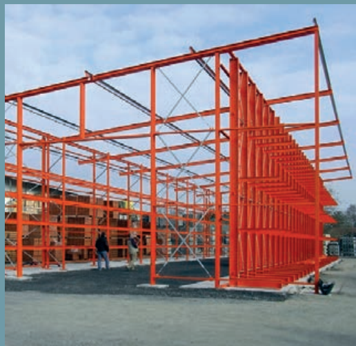
Regálová konstrukce z konzolových a paletových regálů. Nosná konstrukce se štítovou stěnou, krátce před obkládáním. Proveden statický výpočet základových patek a kalichových patek.
