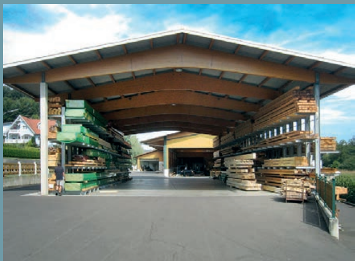
Otevřená hala se dvěma dvouřadými konzolovými regály s žárovým pozinkováním. Moderní konstrukce sedlové střešky se zakrytím trapézovými plechy. Velká základová deska
