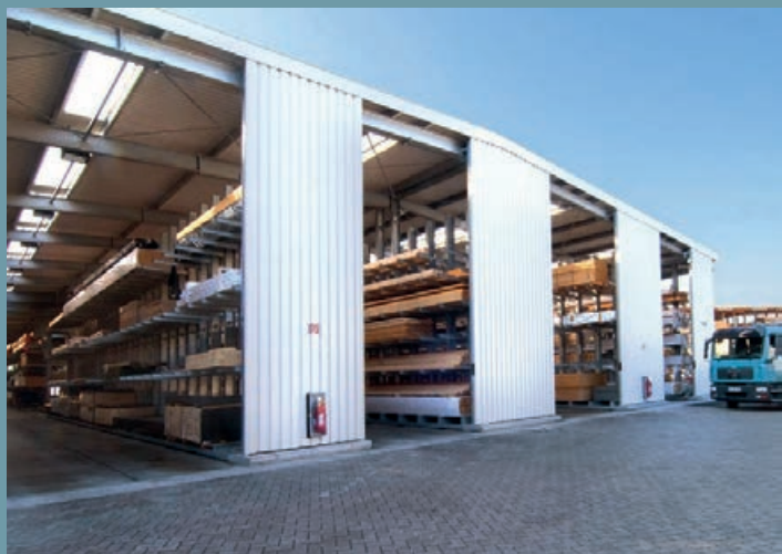
Sklad dřeva s obloženou střeškou a stěnami. Kompletně pozinkované konzolové regály s vodicími kolejnicemi v koncepci skladu s úzkými uličkami. Pásové světlíky v každé uličce.
