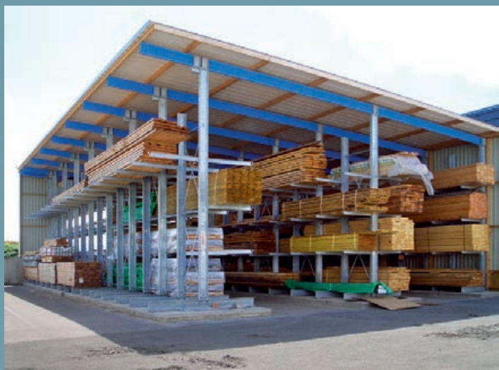
Částečně uzavřená hala s žárově pozinkovanými konzolovými regály. Střeška a stěny z ocelového trapézového plechu. Harmonické rozšíření stávající haly
