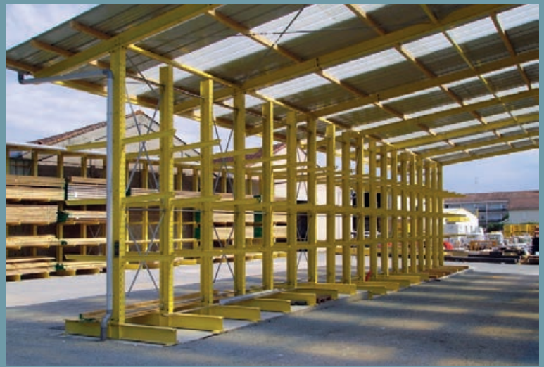
Otevřená hala s konzolovými regály v oblasti obchodu se dřevem. Kompletní se zakrytím střechy trapézovými plechy vč. pásových světlíků, okapových žlabů a spádové trubky. Základová patka s vyrovnáním výšky.
