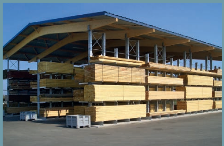
Otevřená hala se třemi dvouřadými konzolovými regály s žárovým pozinkováním. Moderní konstrukce sedlové střechy s 10m rozpětím
