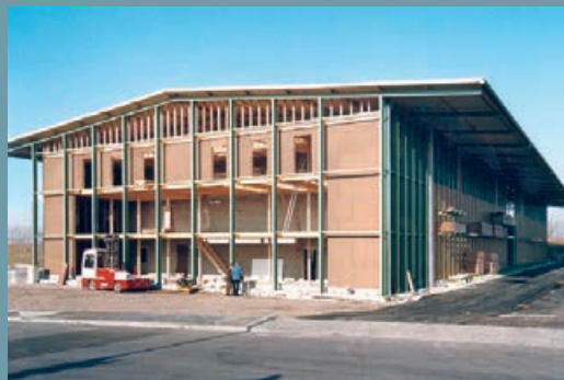
Výstavba regálových hal – uzavřené provedení: Včetně střešní krytiny a obložení stěn. Díky vestavbě vrat, únikových dveří a odvodnění se výstavba regálové haly stává kompletní.
