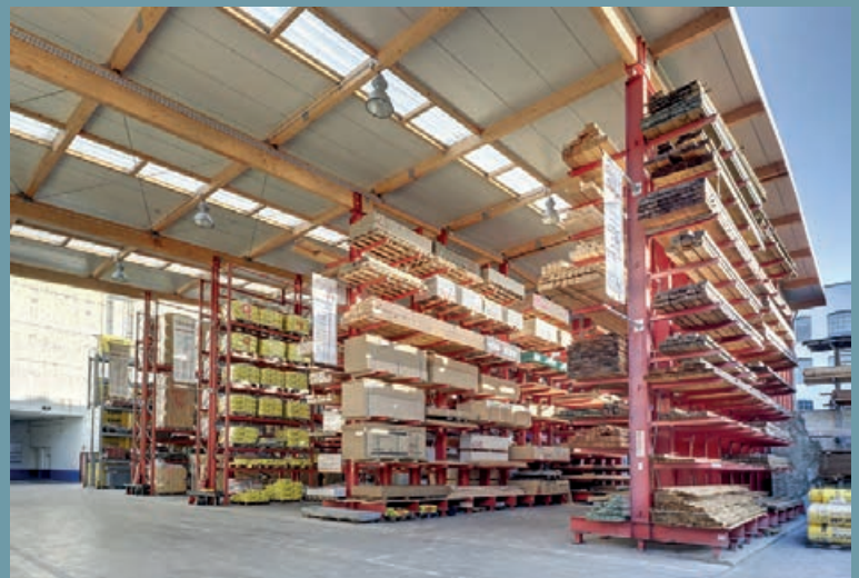
Otevřená regálová hala. Kombinace konzolových a paletových regálů jako nosná konstrukce střechy. Prosvětlené, s velkými rozestupy pro průjezd nákladních vozidel
