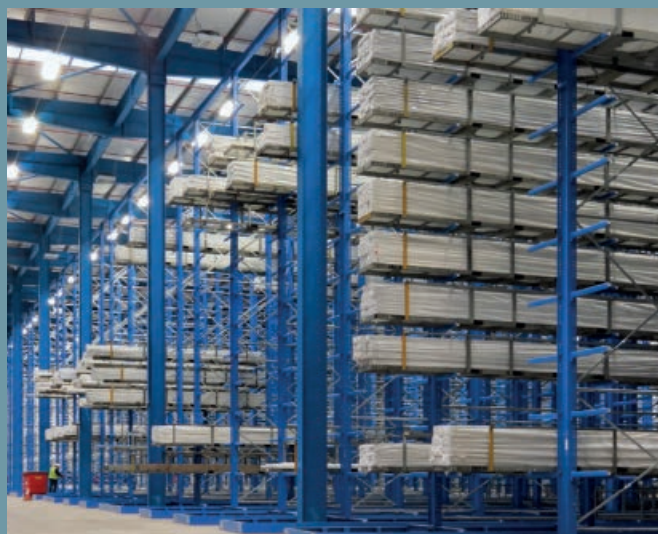
Sklad s konzolovými regály o výšce 13 500 mm se 13 úložnými rovinami na hliníkové a plastové profily uložené v kazetách.
