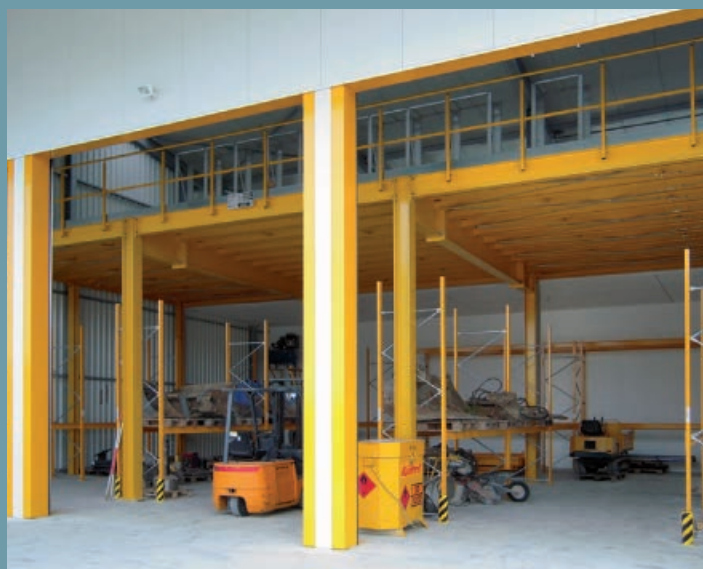
Zkráceno na dostupné rozměry haly. Skladová plošina s regály pod skladovou plošinou a na ní.
